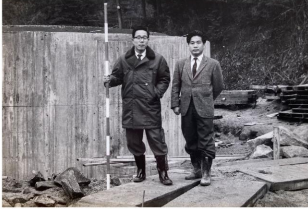
建設現場にて 左側が私(1965年)
