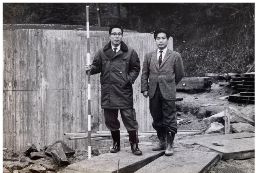
建設現場にて 左側が私(1965年)
