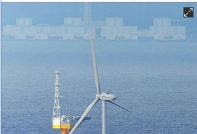
福島県沖の浮体式洋上風力発電施設。奥は東京電力福島第2原発
