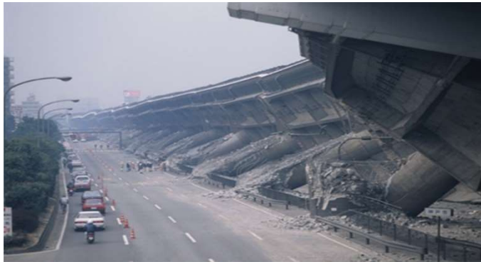
倒壊した阪神高速道路(神戸市東灘区)
