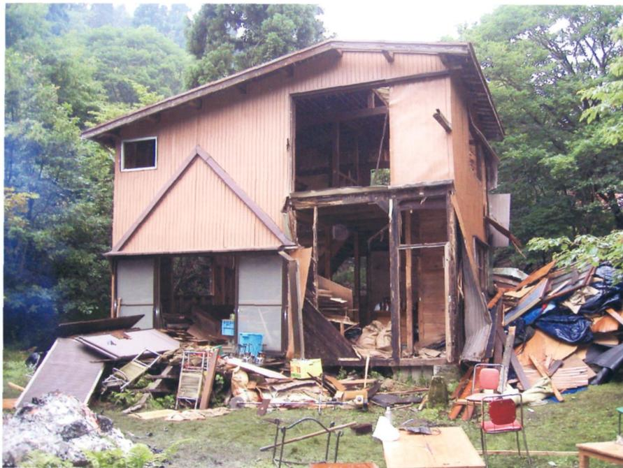
工事はまず山荘の壁と屋根を剥がし、柱と梁の骨組みだけにすることから始まりました。
