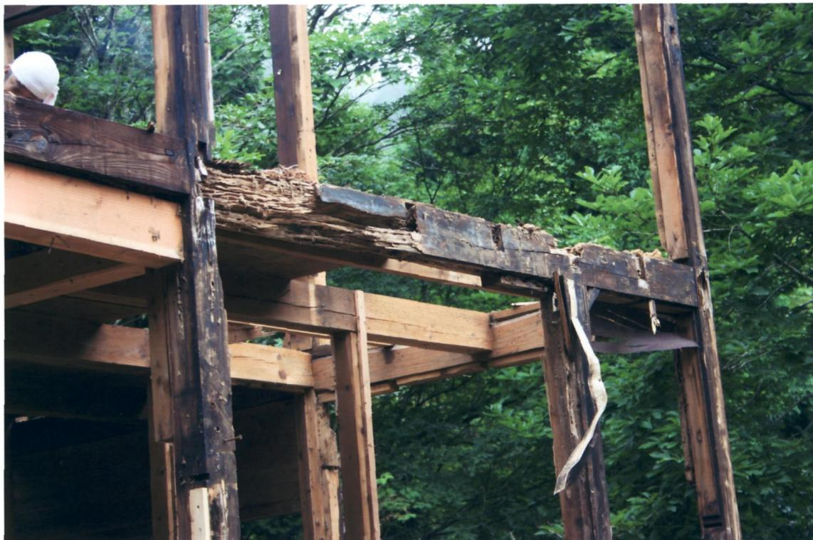
雨水の浸入とシロアリに食われてぼろぼろになっていた玄関上の梁。
